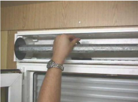
10 Öffnen der Sicherungsfedern
