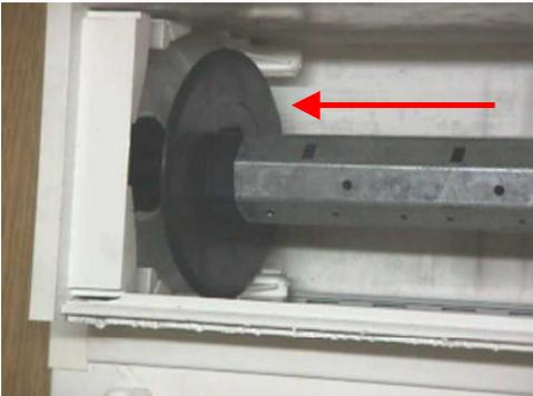
15 Rolladenwelle einsetzen und Seitenscheiben in seitliche Kopfstücke schieben
