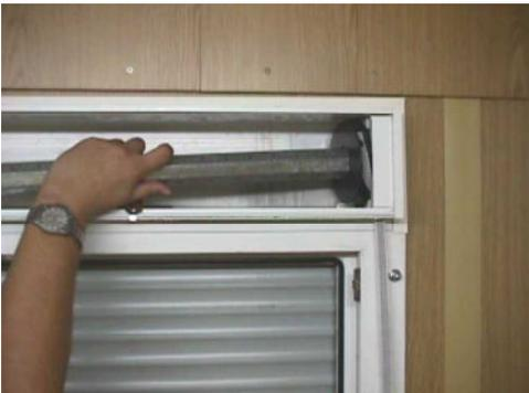
11 Entfernen der Rolladenwelle und Austausch der Lamellen, anschließend Welle wieder einsetzen
